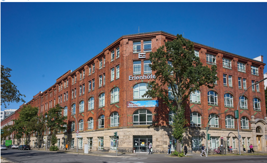
Bildunterschrift: Ansicht des 120m langen, ehemaligen Fabrikgebäudes von Süden. Links zu sehen ist die Arosener Alle, rechts die Holländerstraße, Stand 2023. Quelle: Fotograf Burkhard Schulz © Museum Reinickendorf
