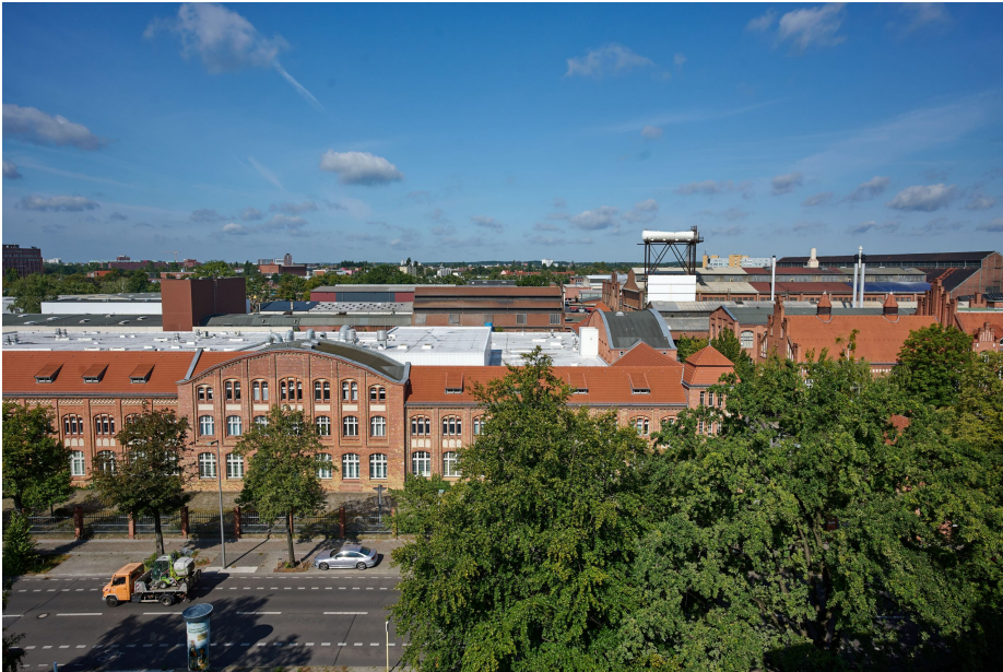
DWM-Kugellagerfabrik am Eichenborndamm, Ostansicht, Stand 2023. Quelle: Fotografie Burkhard Schulz © Museum Reinickendorf
