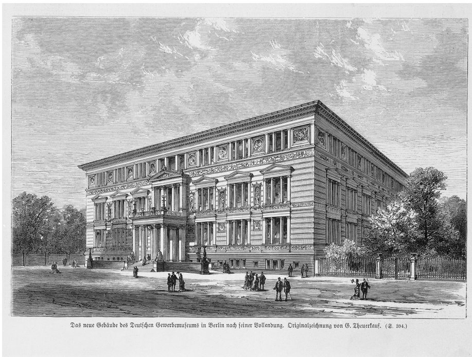
Abb. 1: Deutsches Gewerbemuseum zu Berlin nach seiner Vollendung 1881, Außenansicht, Holzstich nach Gottlob Theuerkauf, abgebildet in: Illustrierte Zeitung, Nr. 1820, 18.05.1878, Bd. 70, S. 397, © SLUB / Deutsche Fotothek / Richter, Regine, lizenziert unter CC BY-SA-4.0 ( https://creativecommons.org/licenses/by-sa/4.0 ) Die postkoloniale Stadt lesen_3.qxp_Layout 1 Kopie 14.07.22 20:55 Seite 70. Quelle: http://www.deutschefotothek.de/documents/obj/89006807
