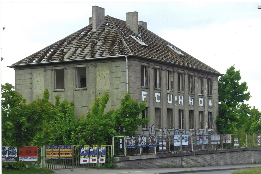
Ehemaliges Wohn- und Geschäftshaus der Elfenbeinbleiche kurz vor dem Abriss 2012. In den 1950er Jahren wird
