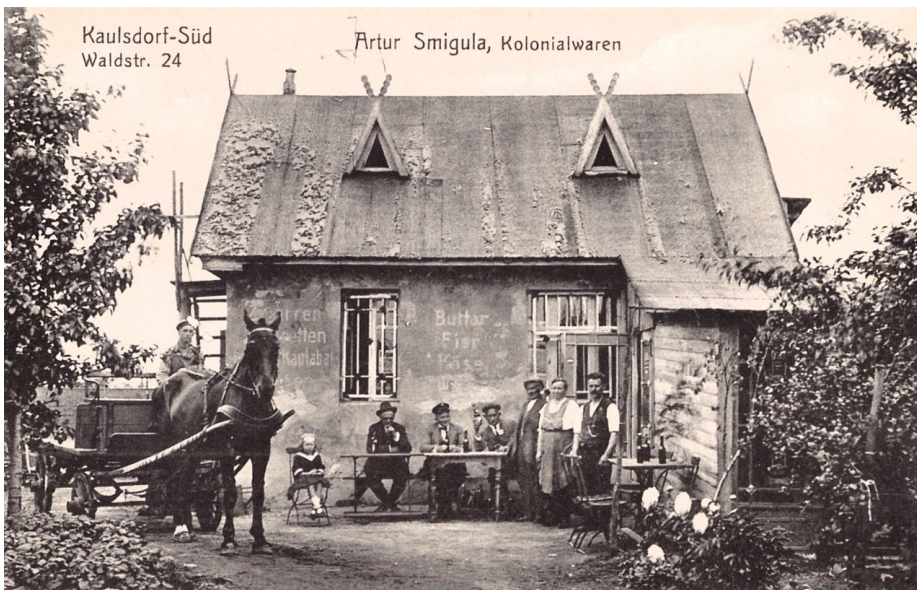
Abb. 1: Ein prunkloser Kolonialwarenladen auf dem Land (1925): Die Posthilfestelle in der Kaulsdorfer Waldstraße 24 fungierte zugleich als kleiner Kolonialwarenladen der Familie Smigula. Die Anschrift auf der Hausfassade gibt Auskunft über das Sortiment: Neben Butter, Eiern und Käse standen auch Zigarren, Zigaretten und Kautabak zum Verkauf. © Sammlung Karl-Heinz Gärtner
